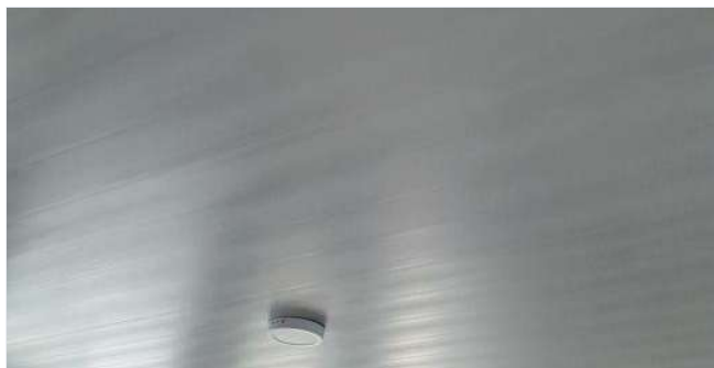
Acabado en cielo raso
