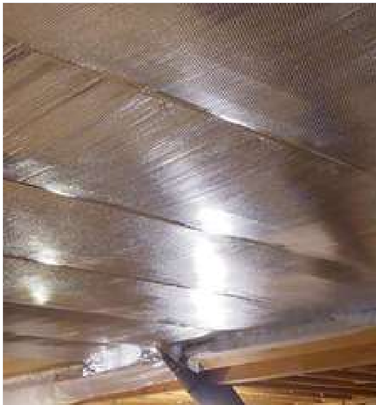
Aislante instalado bajo cobertura
